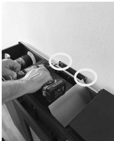
Fig. 26 - Fixação na parede
