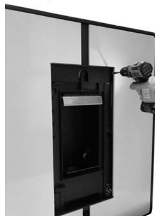
Fig. 41 - Fixação do revestimento
